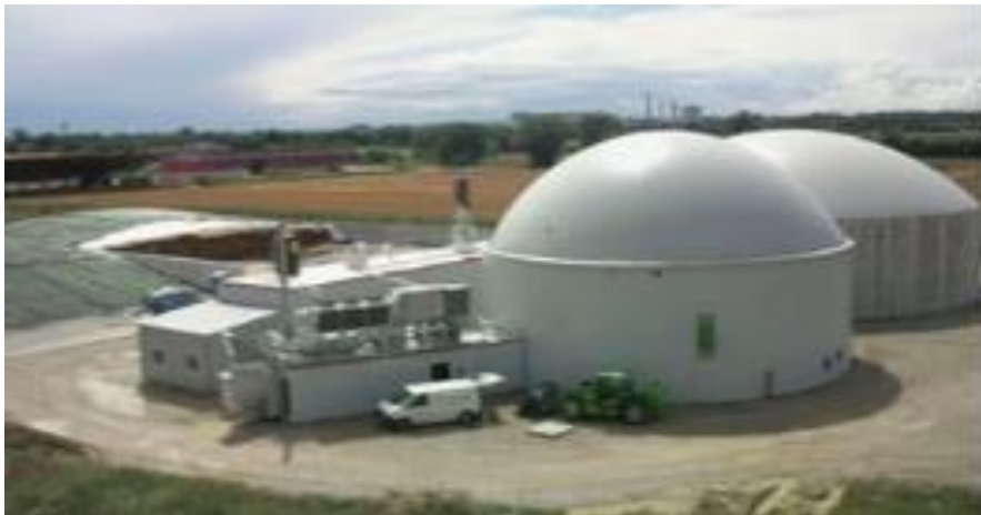
На рисунке – Биогазовая установка в СПК «Рассвет» Кировского района Могилевской области
